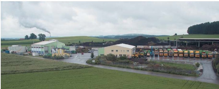
Das Biomasse Kompetenzzentrum in Erkheim produziert aus Abfällen Strom und Wärme
